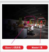
主僕撥碼照明原理:運用藍牙APP技術,將所有主管通過手機APP進行設置; 燈管地址,也可以直接在撥碼開關上直接 設置;一組主管可以帶動多組僕管,實現不同區域不同要求分別控制,操作更加簡單方便。
