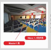
主僕照明原理:運用藍牙APP技術,將所有燈管通過手機APP進行設置,分別將每支燈管的地址碼添加到對應的分組中;一組主管可以帶動多組僕管;每組主僕燈管可以分開獨立控制,實現不同區域不同要求分別控制。
